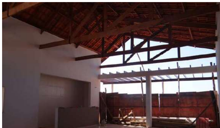
Quiosques e banheiros em construção
