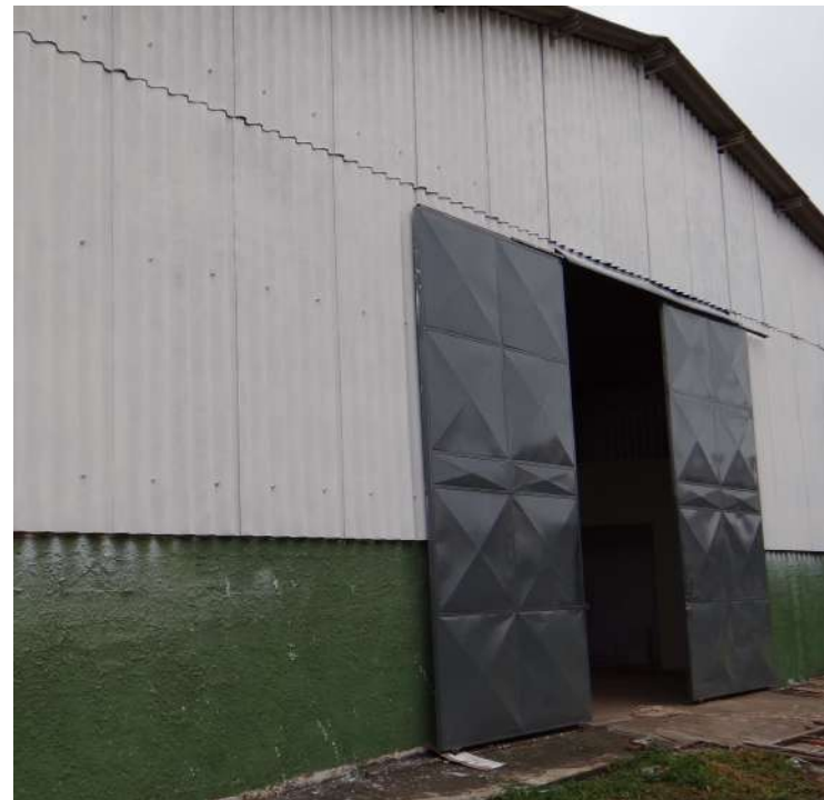
Barracão recebeu reforma e pintura
