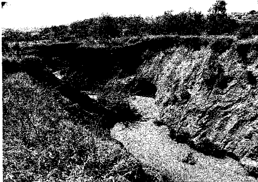
Foto 31: Erosão (ER10) – Parque Ecológico – Av. Espanha (713.127 m E, 7.445.841 m S). Fonte: IPT, 2015.
