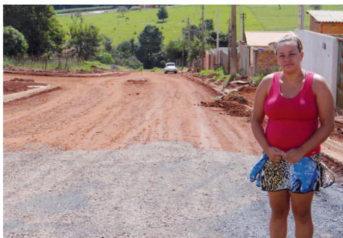
Serviço sendo executados há duas semanas
