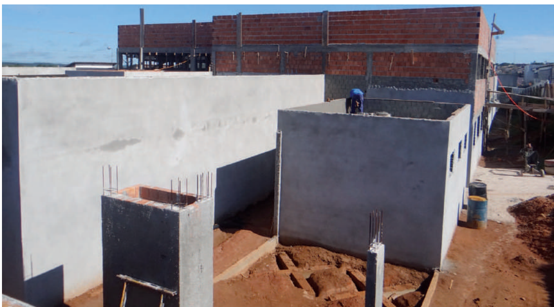
Futuras instalações da Unidade de Pronto Atendimento
