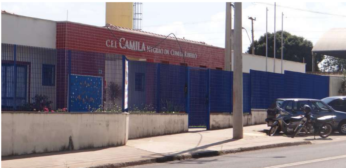
Nova Creche Tipo 1, idêntica à CEI Camila Negrão, será construída no Jardim Dona Laura
