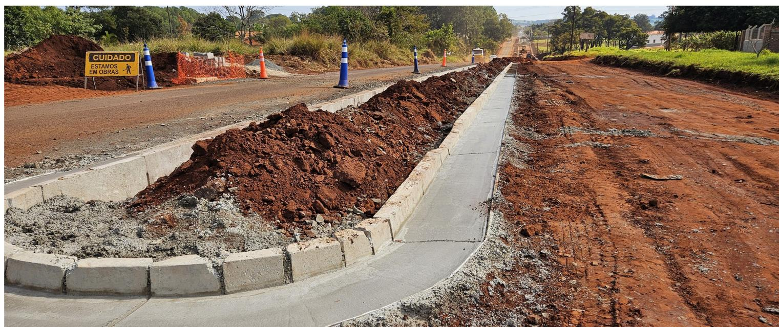
templa a execução de dispositivos de drenagem (bocas de lobo) e a preparação do leito para o recebimento da camada asfáltica, que deve
