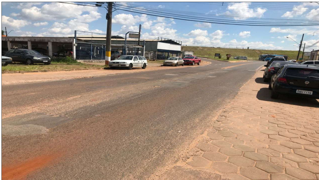
Foto 4. Situação atual da via na Av. Anápolis.
